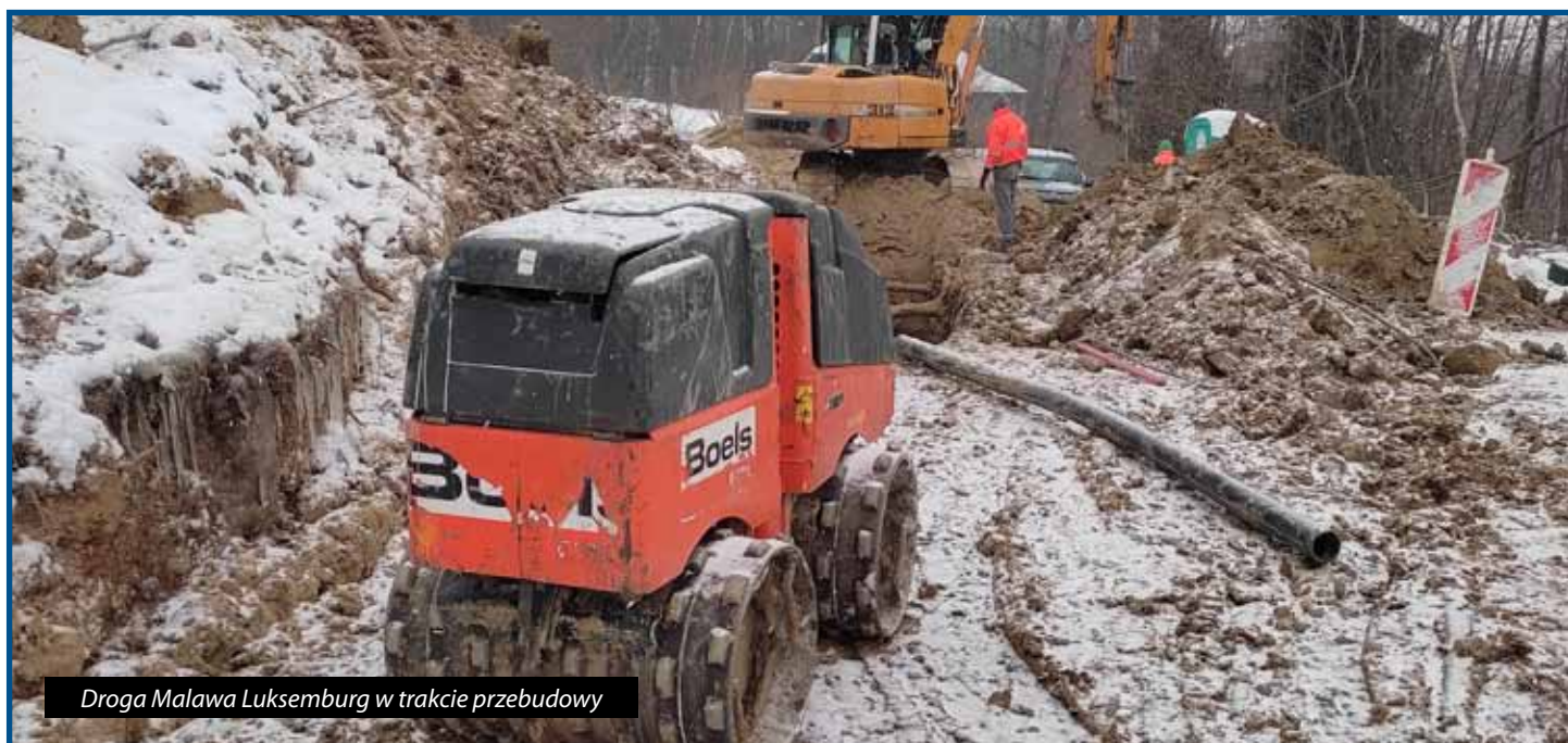
Droga Malawa Luksemburg w trakcie przebudowy
